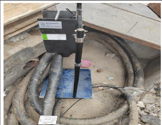
野外探伤验收现场照片(探伤机主射向下)
